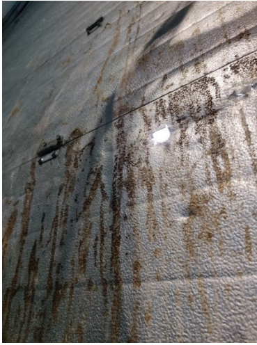
Kuvat 12. ja 13. Kunnostamaton nosto-ovi
