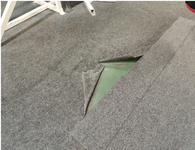
Kuva 3. Yleisen salin lattiamatto
